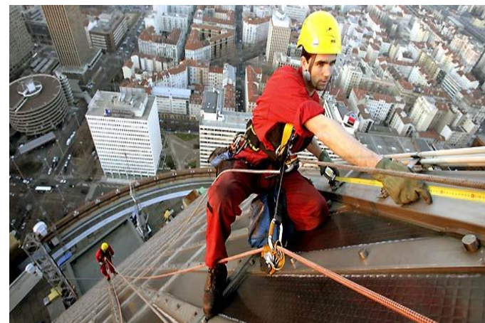
Trabajo en Alturas, andamios, escaleras
